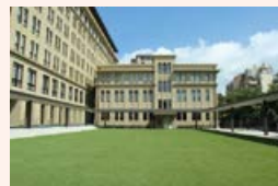
ヒューリックホール京都
