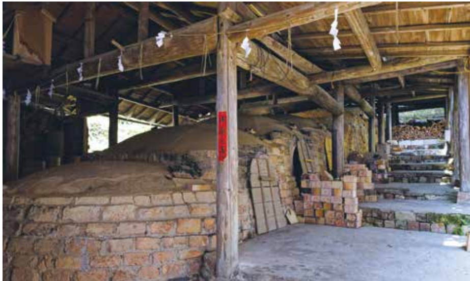
斜面に沿っていくつかの部屋がある登り窯。薪を使って高温で焼く。
